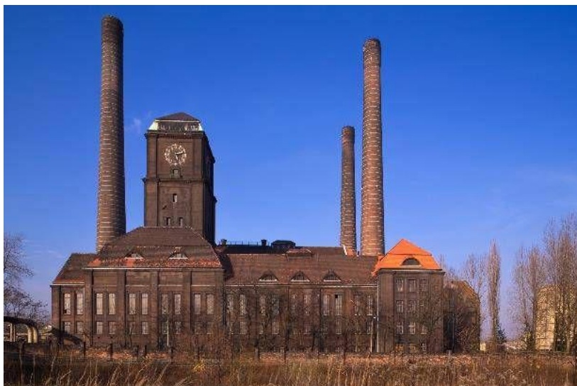
Elektrociepłownia Szombierki ( www.dziennikzachodni.pl/bytom-zabytkowa-hala-elektrocieplovni-szombierki-ma-sluzyc-kulturze/ar/c3-475852 )
