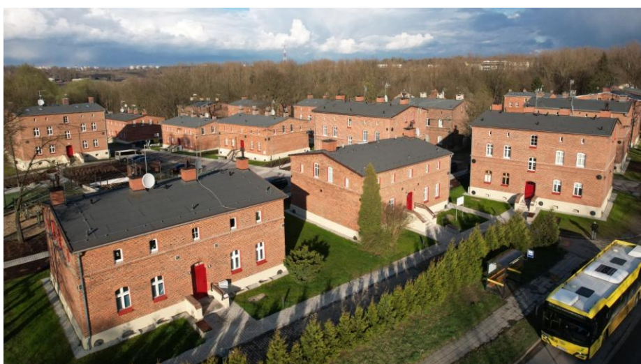
Kolonia Zgorzelec po rewitalizacji - 2024 r. ( https://www.bytom.pl/aktualnosci/ )
